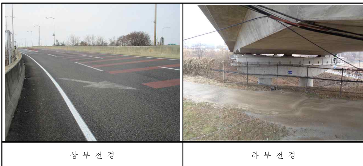
【이산포IC RAMP-I교 전경】
